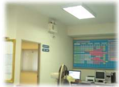
ไฟฉุกเฉิน
