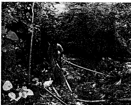
ภาพที่ 4 แสดงขั้นตอนการนำไม้พาดขวางลำน้ำและการใช้แผงไม้ไผ่ฝังลงไปในลำน้ำของฝายกักเก็บน้ำ
