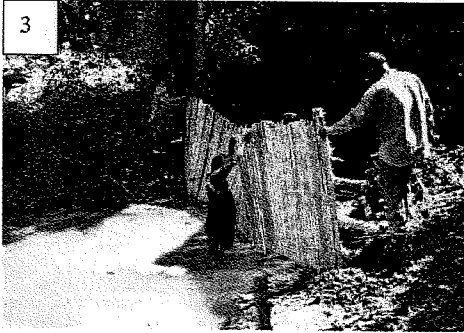
ภาพที่ 4 แสดงขั้นตอนการนำไม้พาดขวางลำน้ำและการใช้แผงไม้ไผ่ฝังลงไปในลำน้ำของฝายกักเก็บน้ำ
